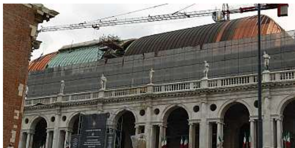
La Basilica Palladiana di nuovo ricoperta con la lamiera di rame. Il restauro continuerà fino al 2010
